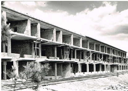
Szpital w budowie
