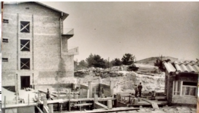
Szpital w budowie
